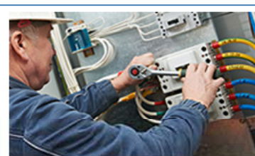
Renove instalaciones eléctricas
